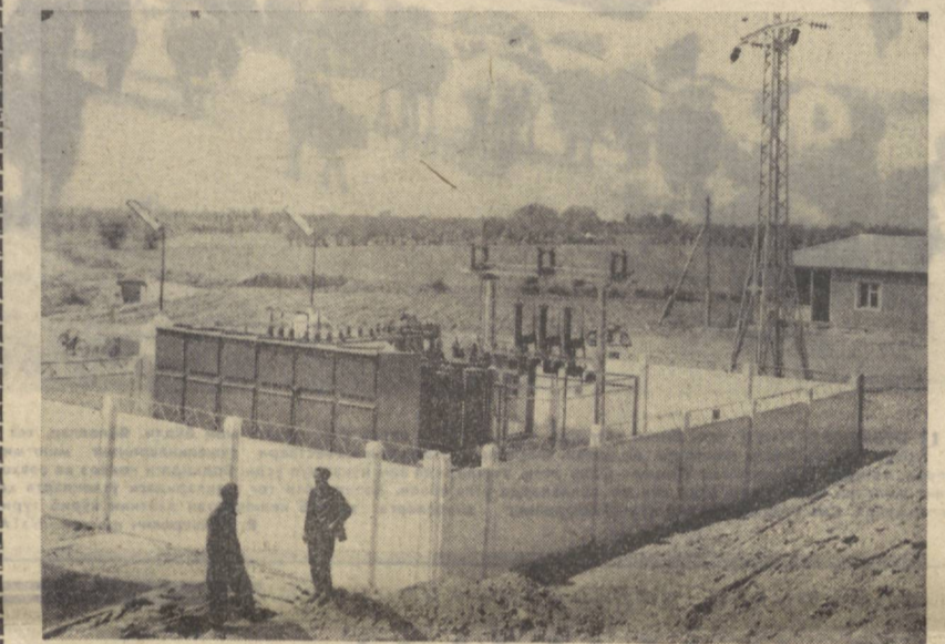
Намангандаги 2-Туваўрғон машина-насос станциясининг дастлабки навбати сув чиқара бошлад. Ана шу иншоот тула-тўқис кўриб тамомланганидан кейин Наманган районидан Саврлов номи колхоз ерлари қўниб сув ичмадиган бўлади. Суратда: машина-насос станциясининг кучлиниши пасайтириш подстанцияси.
