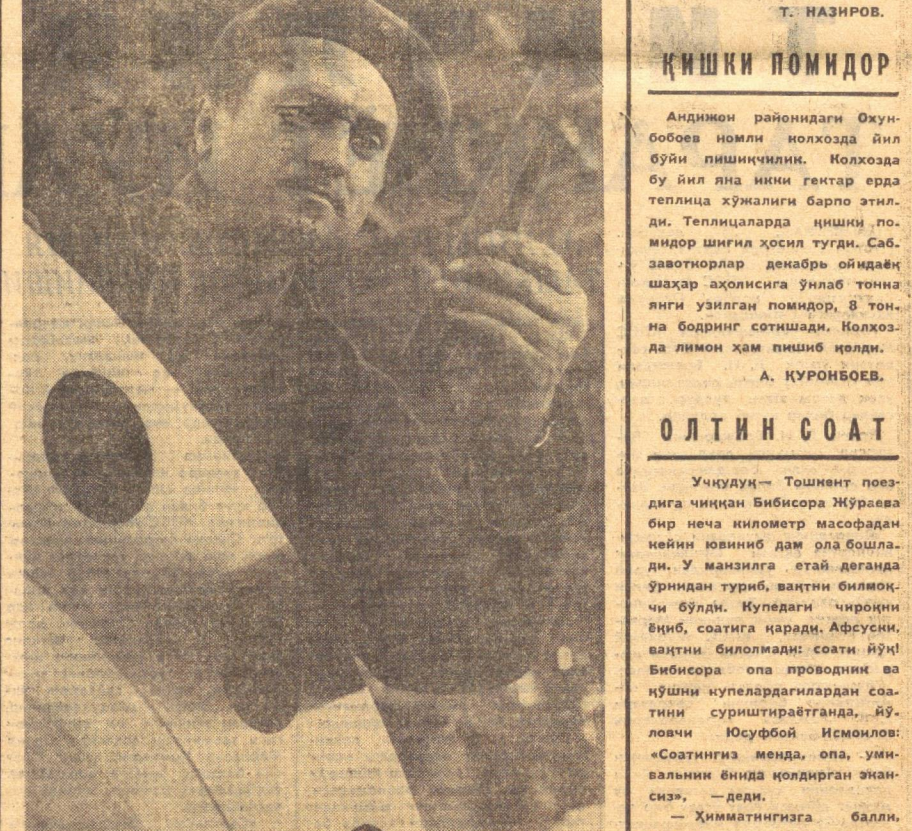
Чорвақ ГЭСда турбаччи турбинани монтаж қилиш ишлари бошлаб юборилди. Монтажниклар бу ишни 1972 йилнинг биринчи кварталда қийингина етказишга натижа сўз бердилар. Суратда: В. Ф. Хомутов турбина генератори ваалини силлажламоқда.
