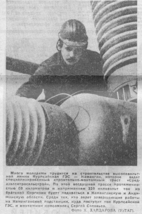
Многие молодые трудятся на строительстве высокотехнологичной линии Курпсайской ГЭС — Наманган, которое ведет специализированный строительный трест «Среднеазиатстройтрест». По этой воздушной трассе протяженностью 60 километров и на протяжении 220 километров ток из братской Киргизии будет подаваться в Наманганскую и Андижанскую области. Среди тех, кто ведет завершающие работы на Наманганской подстанции, куда поступит ток Курпсайской ГЭС, и монтажники комсомолец Сергей Соловьев. Фото X. ХАЛДАРОВА (УЗТАТ).
