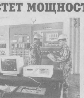
перевыполнено задание по производству сжиженного газа. В эти дни быстрыми темпами ведется строительство пятого газоочистительного блока. Это даст возможность очищать 4 миллиарда м³ газа.
