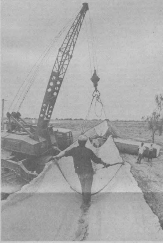
Ввод в строй первой очереди третьей Диназганской насосной станции позволил улучшить условия полива во многих садоводских хозяйствах Голландии. Чтобы направить сырдариноскую воду в эти места, пришлось поднять русло на высоту в 113 метров. На СНИИМХАХ, сверху — три километра оросительных лотков установила бригада И. Мухомова из ПМН № 18 треста «Гидрострой» от третьей насосной станции; справа сверху — главный инженер треста «Гидрострой» В. Тамаев и главный ирригатор совхоза имени К. Рахимова Дустанского района М. Рустамов; поля хлопчатника в совхозе «Ленин югов» проволот трубными проходами через борозды.
