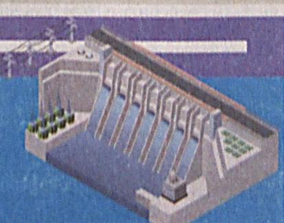
По поручению Президента высота плотины водохранилища была увеличена на 20 метров. В результате его вместимость доведена **с 380 миллионов до 500 миллионов** кубометров. Сейчас ведутся работы по монтажу еще двух агрегатов общей мощностью 145 мегаватт. Кроме того, строятся малые гидроэлектростанции Зарчоб-1 и Зарчоб-2, мощность каждой - почти 38 мегаватт. Таким образом, общая мощность выработки энергии будет доведена до **250 мегаватт**.
