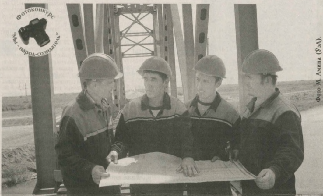
Строители треста № 67 - "Куприкунжиддин Тургунов (бригадир), Туйчибой Аскар, Мансур Раимжонов (слева - направо) сооружают новый мост на участке "Янгйобод - Даштобод" по железнодорожному направлению "Ташкент - Самарканд".
