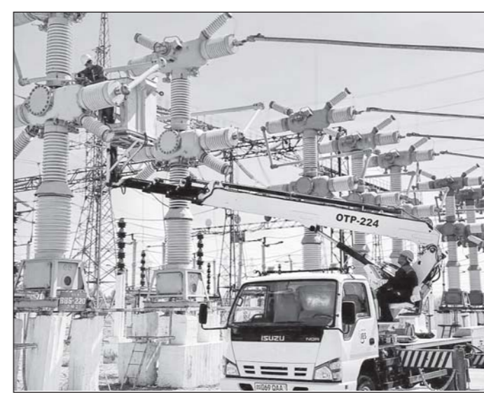
Ба мақсади омодагирӣ ба мавсими тирамоҳу зимистони соҳаи 2024-2025 дар НБҶ-и Сирдарё корҳои таъмири нақша ба роҳ монда шудаанд. Аз ҷумла, дар хатти ЛМ-2 сохтори тақсимкунии неруғаш 220 кВ, ки тобеи сеи электрики корхона мебошад, корҳои таъмир дар арафаи анҷомёбанд. Ҳамчунин, дар қисмҳои ҳавогузарони истеҳсол нисзи камбудии нуқсонҳо бартараф карда мешаванд. Баъди ба анҷом расидани корҳо дар истеҳсоли мазкур сифати бо энергияи барқӣ таъминкунии истеъмолгарон беҳ мегардад. Дар акс: рафти корҳои омодагирӣ ба мавсими тирамоҳу зимистон.
