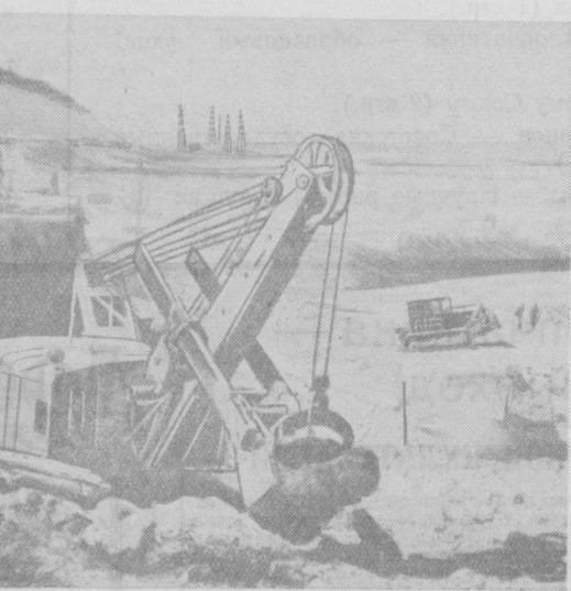
Куйбышевгидрострой. Оживленно на площадке, где роется котлован под здание Куйбышевской ГЭС. Непрерывным потоком идут автосамосвалы с грунтом, мощные экскаваторы работают в котловане в несколько ярусов. Многие из них вынимают грунт уже с 30-метровой глубины. На снимке: трехкубовый экскаватор «Уралец» вынимает грунт со дна котлована.
