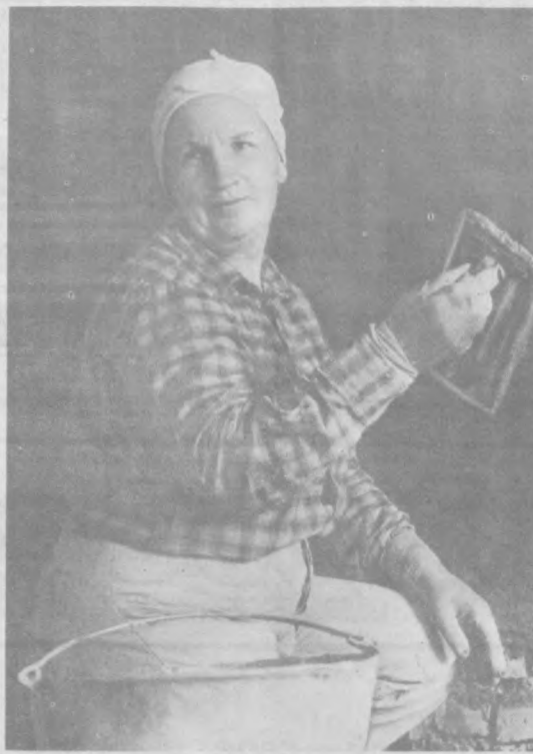
На самые ответственные участки работы направляют в СУ «Ташгестрой» бригаду отделочников под руководством А. Ф. Марсюк.
