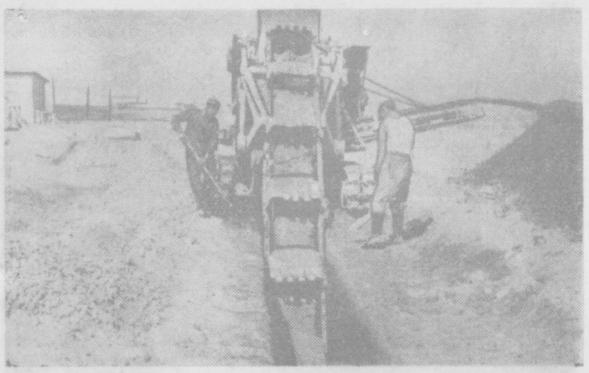
Ташкентская область. В Янги-Ере для понижения уровня грунтовых вод строятся закрытые водосбрасывающие дренажные устройства. На снимке: прокладка траншей многоковшовым экскаватором в Янги-Ере.
