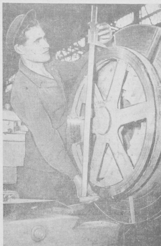
Соревнуясь за достойную встречу 41-й годовщины Великого Октября, токарь завода «Таширман» Василий Викторович Ишук стал на трудовую вахту в честь праздника. Он выполняет полторы и более норм в смену. На снимке: В. В. Ишук за обработкой зубчатого колеса к главной лебедке экскаватора.
