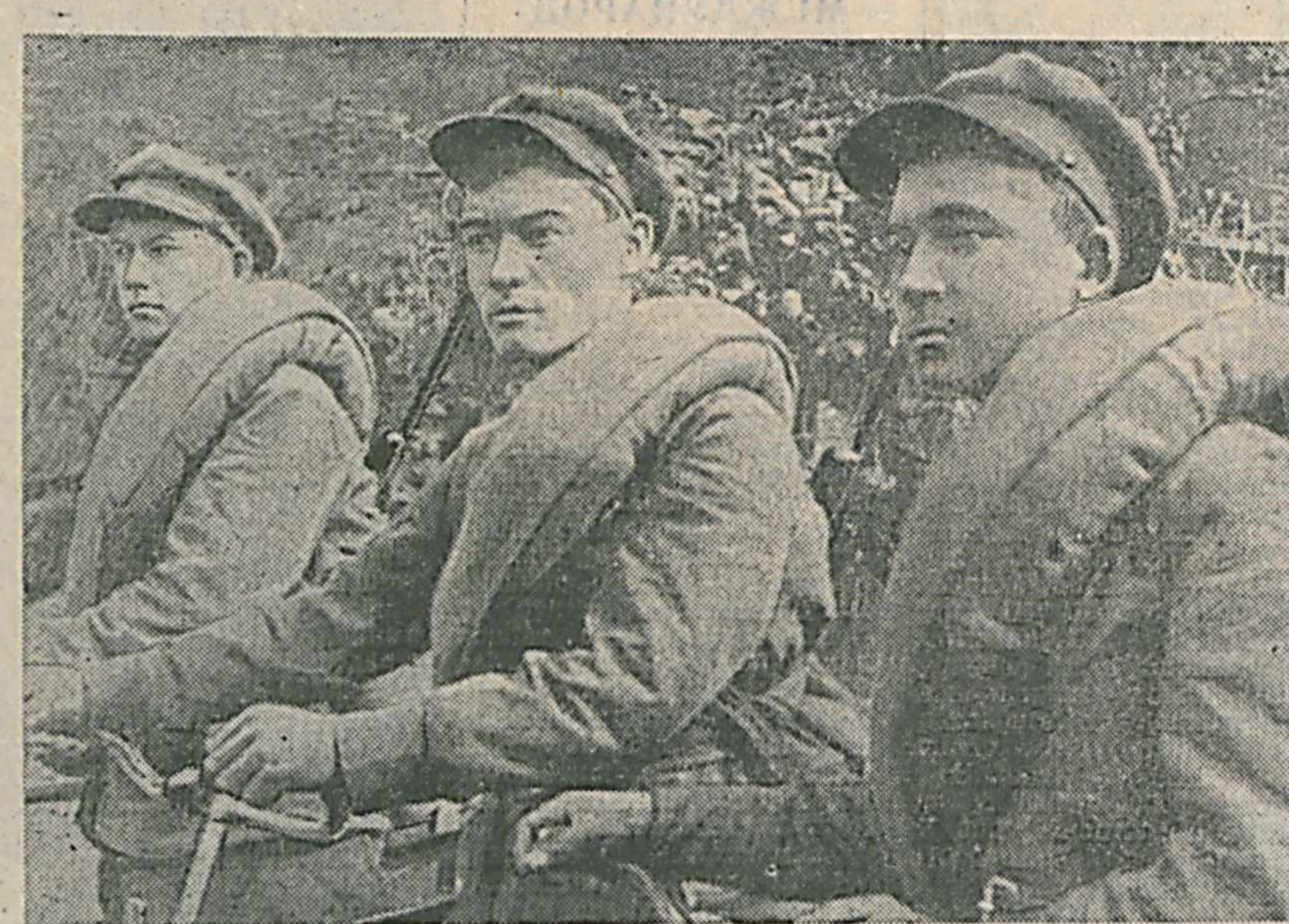
Суратда (чапдан ўнга): А. Хўжаев, Ҳ. Иноятлов ва А. Иброҳимов. Москва, 1935 й.
