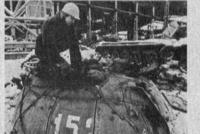
Одним из последних пунктов назначения для более чем ста танков стала площадка Новосибирского областного объединения «Вторчермет». За короткий срок специалисты разработали особую технологию разделки машин для того, чтобы отправить их на металлургические заводы. «Сдаться без боя» танкам позволил происходящий в нашей стране процесс конверсии и сокращения Вооруженных Сил.
