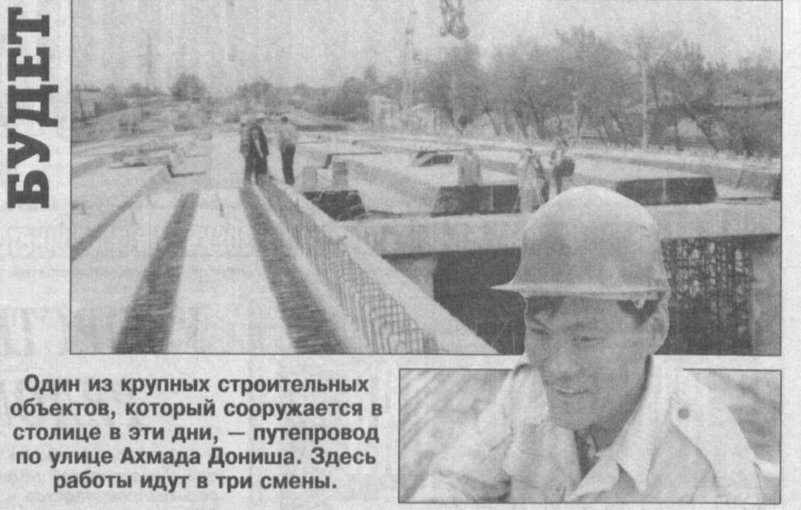
Один из крупных строительных объектов, который сооружается в столице в эти дни, — путепровод по улице Ахмада Дониша. Здесь работы идут в три смены.
