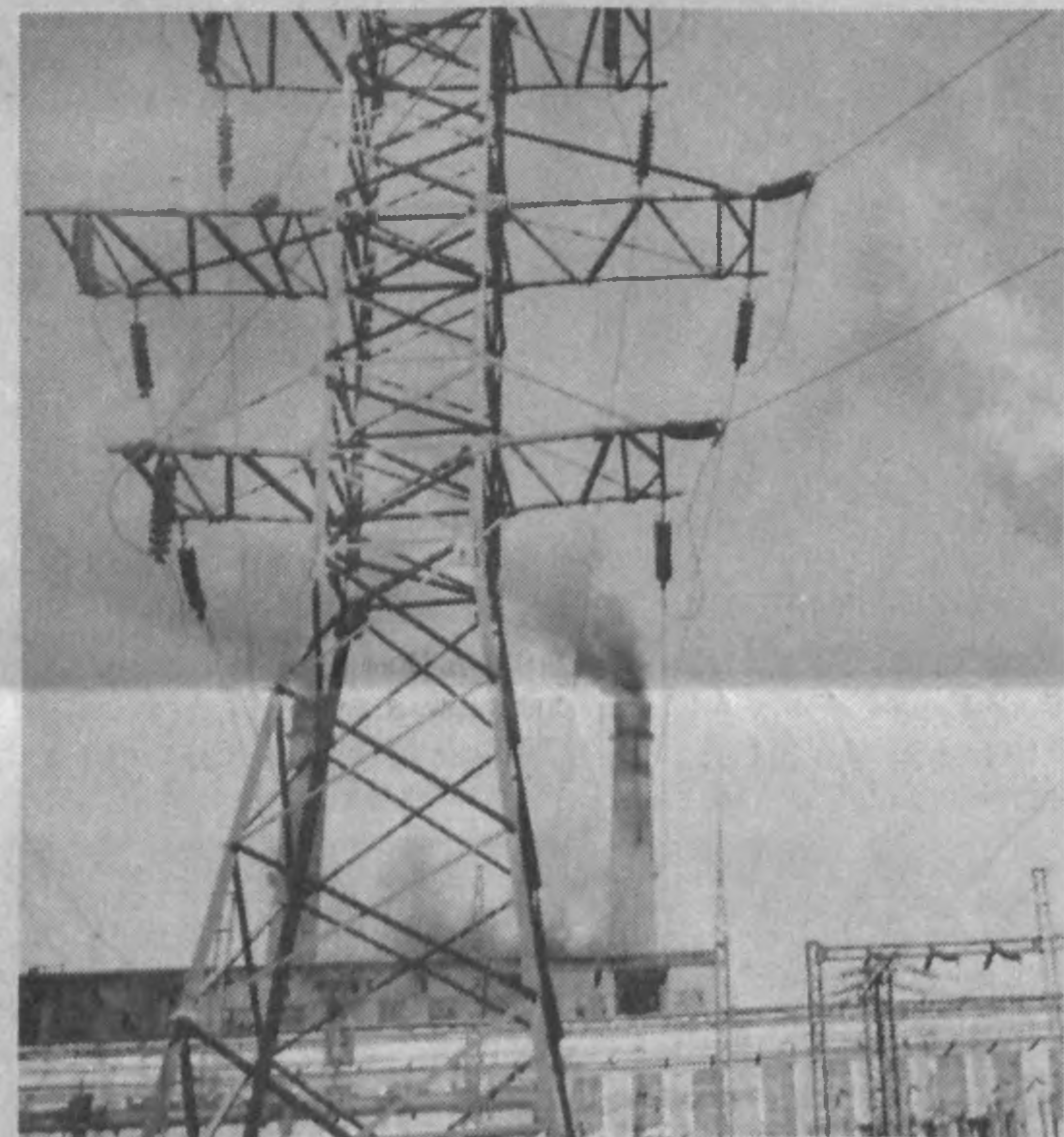
Ферганскую часть энергосистемы со строительством приемной подстанции в районе г. Коканда. Это позволит значительно повысить устойчивость электроснабжения потребителей Ферганской долины.
