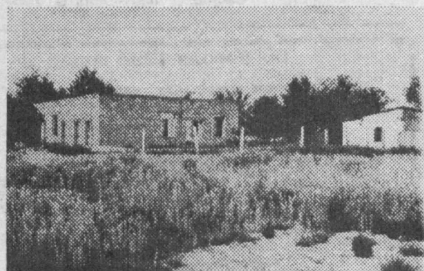
Незавершенное строительство чайханы, г. Гиждуван
