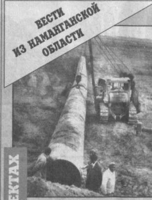
Вестник Наманганской области. На пусковых объектах. Генеральным подрядчиком стала первая ПМК треста «Наманганкирчилик», находящаяся в Чусте. Здесь в высоком темпе ведутся ремонтные и строительные работы. Установлены 6 новых насосов. На первой линии, уже готовой к пуску, протяжены 1,400-миллиметровые трубы, способные подавать полтора кубометра воды в секунду — это в два с лишним раза больше, чем раньше.
