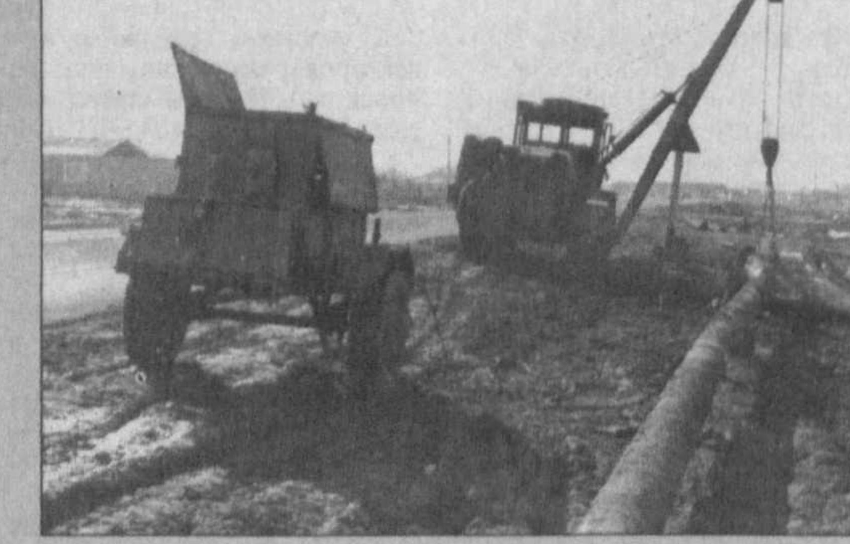
НА СНИМКАХ: начальник участка Пириез Жиймуратов, слесари Азирбой Калекеев и Саги Абдуллаев; строители Нукусского строительно-монтажного управления АО «Узбекгазсувкурилиш» ведут ремонт газопровода в старой части города Нукуса. Фото Амандия МУРАТОВА. УЗА.
