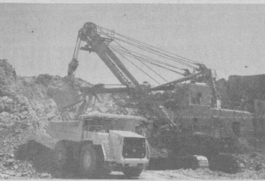
ваторов, подающих на-гора одновременно до 15 кубометров горной породы, 80—100-тонный гигантский автотранспорт поднимает наверх огромные валуны, которые затем по железной дороге отправляются на меднообогатительную фабрику.
