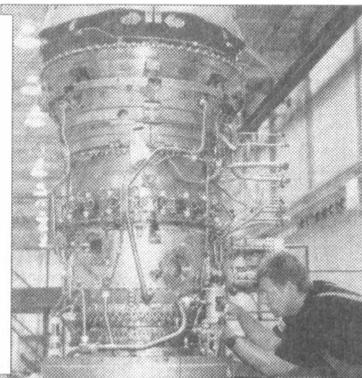
**НА СНИМКЕ:** конечная фаза сборки нового двигателя, предназначенного как для самолетов, обслуживающих деловые полеты руководящего персонала фирм, так и для британских самолетов морской разведки. Двигатель отличается экономичностью в расходе топлива.
