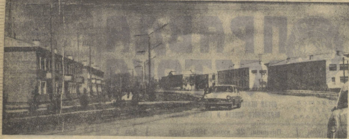
Еще недавно на месте улицы Индустриальной в г. Карши был пустырь. Теперь здесь — стали бласустроенные дома осветителей Каршичской теплицы. Фото М. Чернова.
