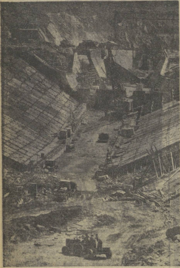
Строители Чарваинской ГЭС готовятся 30 сентября перекрыть реку Чирчик. Сейчас заканчиваются работы по сооружению отводного канала. На верхнем снимке: лучшие строители передовой комплексной бригады (слева направо) Роза Василова, Туляй Рахманов, Василий Кишино, Владимир Рогожинков, бригадир Михаил Мурашов и Юрий Борисов. На нижнем снимке: вид строительства отводного канала.
