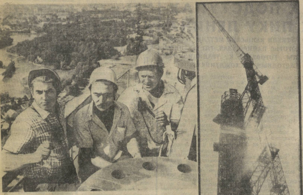
Монтажники управления № 26 треста «Спецстройинструкция» на строительстве Ташкентской телевизионной вышки достигли высоты 101,6 метра. На этой отметке начнется монтаж технического этажа...
