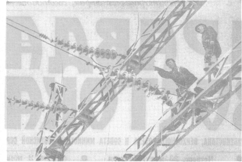
Один из участков монтажа линии высокочастотной передачи, берущей начало на Караганской ГЭС.
