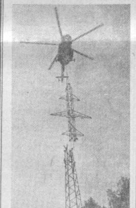
ТРЕСТ «Западсентроэнергострой» электрифицирует нефтегазодобывающие районы Западной Сибири. Коллектив интенсивно ведет передовые методы строительства линий электропередачи и магистральных газотранспортных систем. Широкое применение находят вертолеты. На снимке: вертолет «Ми-8» монтирует на Сургут-Быстринском нефтяном месторождении секции опоры ЭПЛ-110.
