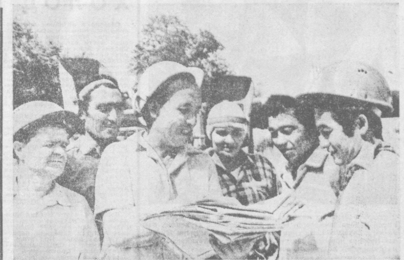
Передала комплексная бригада строительного управления № 1 треста «Вострой», возглавляемая бригадиром Петром Филипповичем Сачко, участвовала в строительстве многих зданий в столице республики, в том числе Музея дружбы народов СССР и Монумента мужества. Сейчас она отбывает труды на возведении административного здания по улице Ленинградской. На снимке (слева направо): А. Лускин, В. Чалала, П. Сачко, В. Пученкина, Р. Турдыев и А. Аскаров.
