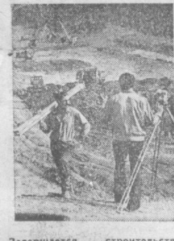
Завершается строительство комплекса гидротехнических сооружений в Лениногорском районе Азербайджанской ССР. В него входят водозаборные сооружения на горных реках, которые наполняют Ханбулагское водохранилище с деривалом в 1,240 гектаров, оросительные каналы, насосные станции. На снимке: геологист Муртуз Бузууров (слева) и Шахмарал Шахмуратов на строительстве плотин.
