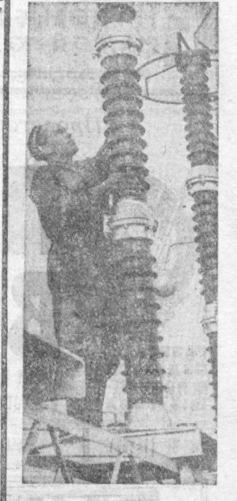
Закончился монтаж новой электростанции «Зауран», которая будет давать электроэнергию всему Ходжабадскому району и нефтепромыслу «Южный Аламшаркан». На снимке: монтаж И. Усманов за регулировкой разрядника. Фото С. ВЕЗНОВОА.
