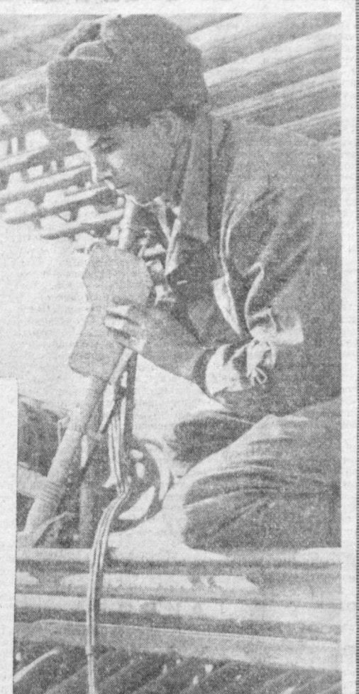
В Каракалпакии автономной республике развернулось строительство третьей очереди Тахташатской ГРЭС. К юбилею Великого Октября мощность станции увеличится на 100 тысяч киловатт. На снимке: один из лучших монтажников стройки Роберт Антипов.
