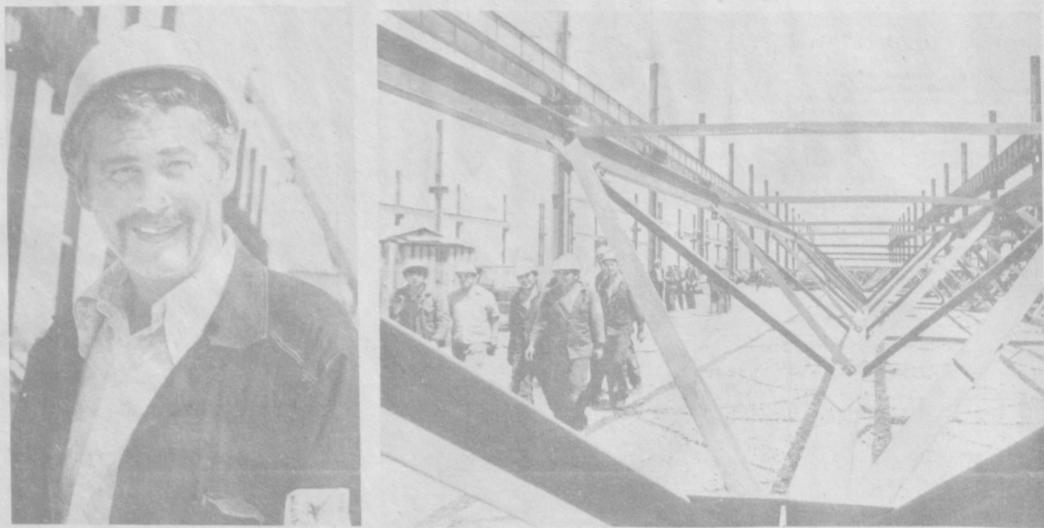
Установлен последний подкос. Процесс взвинтил гайки в руках Сергея Мешкова, и звеньевую, вытирая пот, с улыбкой сказал: «Жарко! Пора бы и побороть». Всего за четыре часа собран блок пространственного покрытия. Следом «выложил» свой блок звено А. Коваленко...
