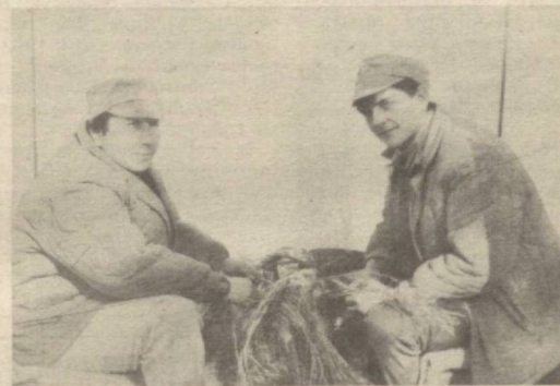
Монтаж кабелей требует большого умения и профессионального мастерства. Высококвалифицированные кабельщики Абдужаббар ИРГАШЕВ и Александр ПОТАПОВ монтируют муфту.
