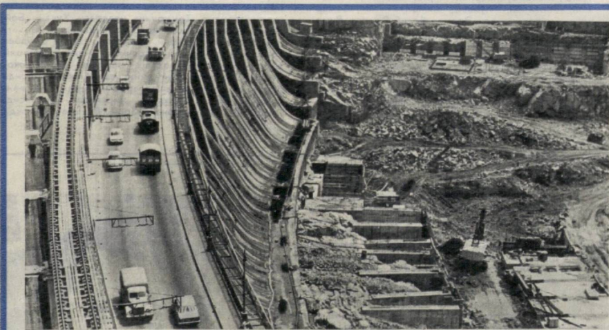
Мамлакатимизнинг дастлабки йирик нур манбаларидан бири — В. И. Ленин номидаги Днепр ГЭСи қурилганига 40 йилдан ошди. Ҳозир иккинчи Днепр ГЭСи қад кўтармоқда. Суратда: қурилиш котлованида
