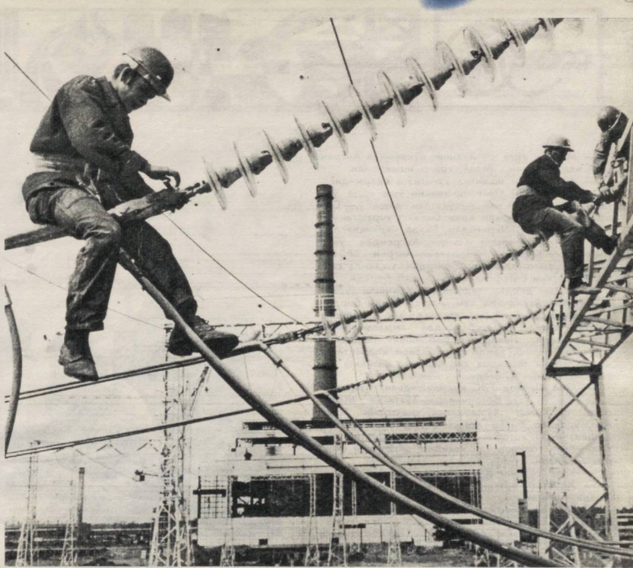
Зиновий Кузьмин бошлиқ бригада ГРЭС кичик станциясининг изоляторларини монтаж қилмоқда.
