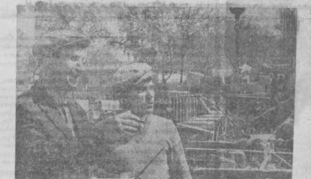
Свердловск бинокорлари ишлаётган объектда биринчи бинонинг ноё қисми тугалланмоқда. Суратда: [ундан нага] Свердловск қурилиш поездининг бошлиғи В. Алпатковга навбатдаги курсатма бермоқда. Н. МУҲАММАДЖОНОВ фотолари.
