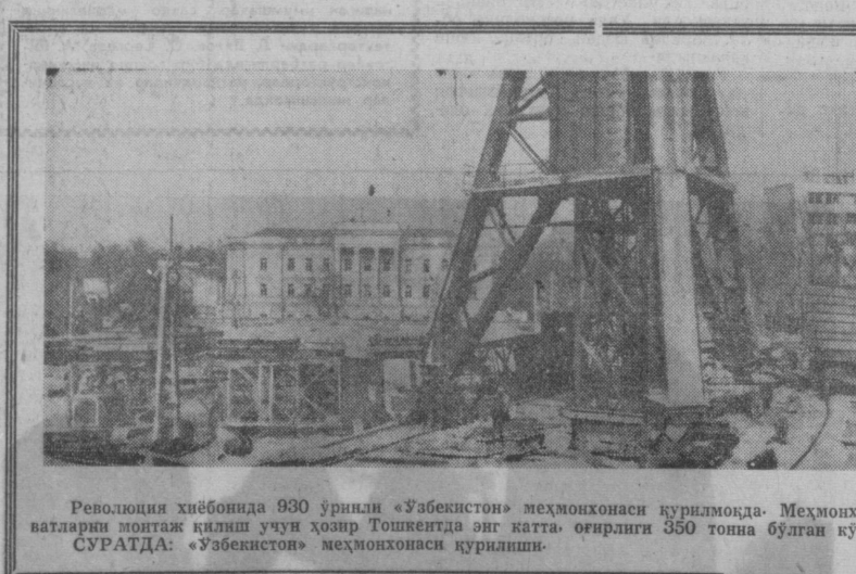
Революция хиббонда 930 ўрикли «Ўзбекистон» меҳмонхонаси қуришмоқда. Меҳмонхона 17 қаватдан иборат бўлади. Юқори қаватларни монтаж қилиш учун ҳозир Тошкентда энг катта оғирлиги 350 тонна бўлган кўтарма кран монтаж қилинган. СУРАТДА: «Ўзбекистон» меҳмонхонаси қурилиши.
