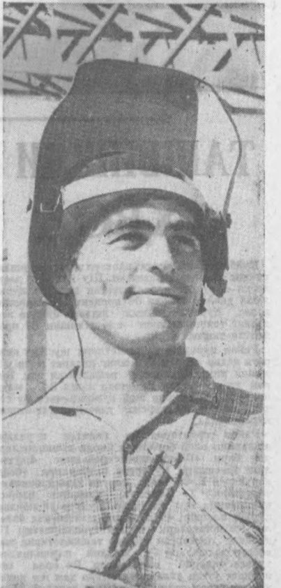
Электр пайвандчи Аҳмад Тожибоев «Сталь-монтаж» бошқармасининг пешқадам монтажчиларидан бири.
