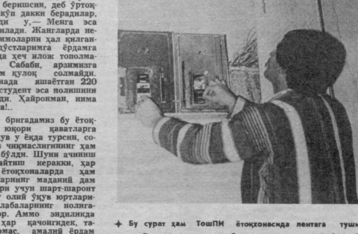
Бу сурат ҳам ТошПМ ётоқхонасида лентига туширилган. Топадан электр ҳисоблагичларга чакка ўтиб ётибди. Бундай ҳол ёгинга олиб келмаслигига ким кафолат бера олади!
