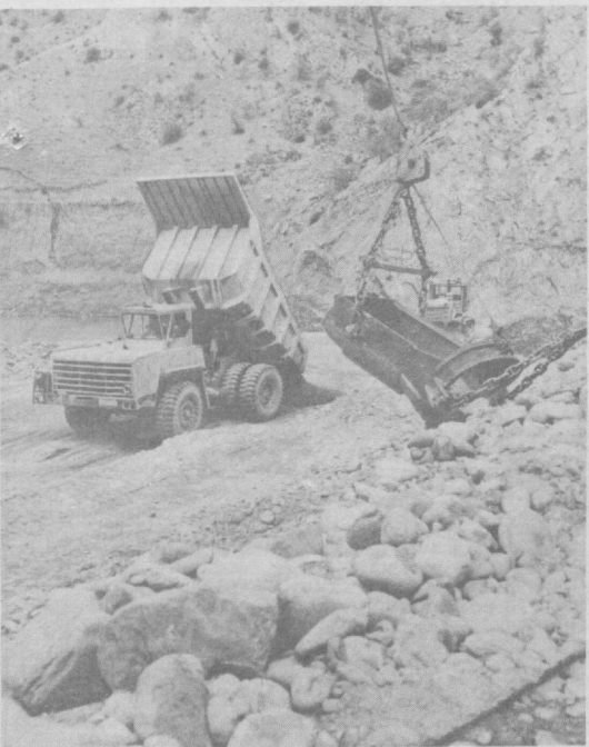
На реке Туполанг идет отсыпка плотины — закончен трудный этап подготовительных работ.
