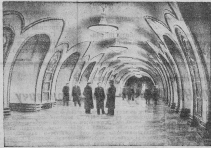
Москва. На пусковом участке Большого кольца метрополитена. На снимке: подземный вестибюль станции «Повослободская».
