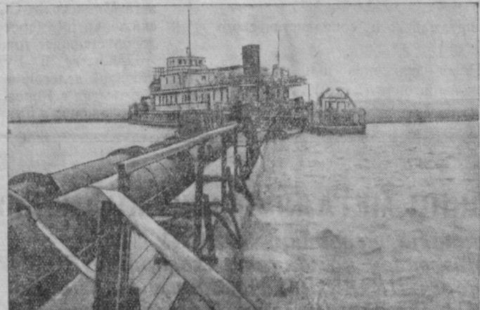
В предмайские дни строители Главного Туркменского канала получили первые мощные земснаряды, выпущенные коллегией Горьковского завода «Красное Сормово». Земснаряд «Сормович-7» имеет увеличенную производительность — в течение одного часа он промывает 350 кубометров грунта. Конструкция механизма приспособлена к работе в специфических условиях Кара-Кумов. На снимке земснаряд ведет насыпку правого берега Аму-Дары.
