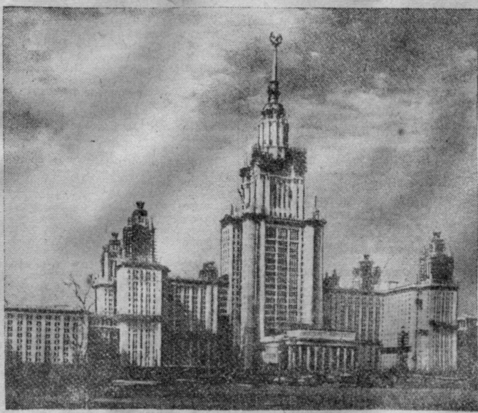
Москва. Строительство Московского государственного университета на Ленинских горах. Фото Н. Грановского. (Фотохроника ТАСС).
