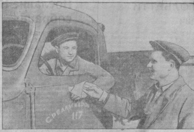
Один из передовиков соревнования автономным «Среднегидростроит», работающей на строительстве Главного Туркменского завода, директор самосвала Анатолий Матусевич ежедневно норму перевозок гружен самосветом выполняет на 150-200 процентов. На снимке: старший диспетчер С. Андреев вручает А. Матусевичу путевку в очередной рейс.
