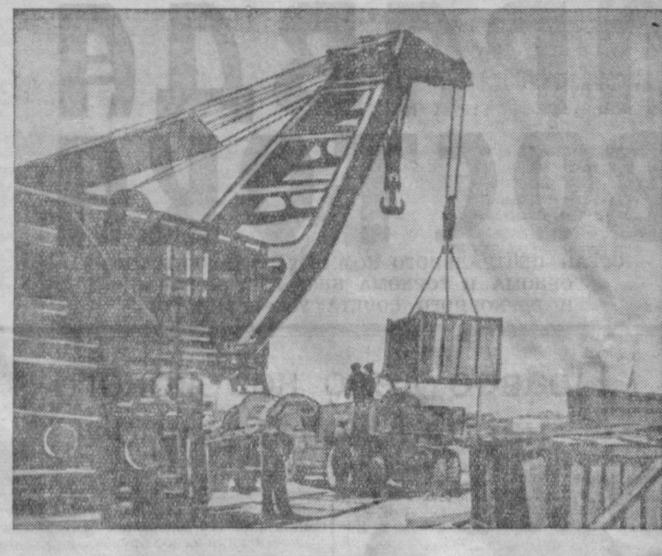
На станцию Тахи-Таш ежедневно поступают материалы, машины, станки для строительства Главного Туркменского канала. На снимке: железнодорожный 25-тонный кран грузит на автомашину прибывающие станицы. Фото О. Кузьмина. (Фотохроника ТАСС).
