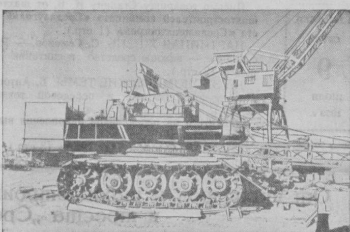
На монтажных площадках главной конторы механизации строительства Главного Туркменского канала идет сборка семикубовых электрических экскаваторов, предназначенных для ряда котлованов под гидроузлы. На снимке: монтаж второго семикубового электрического экскаватора в Ташкенте.
