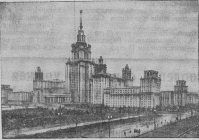
Москва. Строительство высотного здания Московского государственного университета на Ленинских горах. Фото Н. Грановского. (Фотокорреспондент ТАСС)
