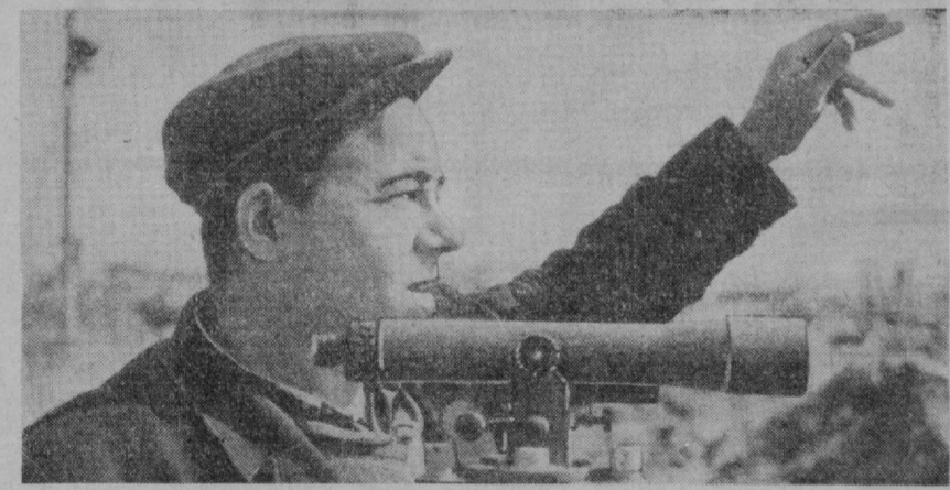
На окраине Ферганы началось строительство завода искусственного волокна — одного из предприятий химии страны. Основным исходным сырьем для него является бухарский газ. Все сложные технологические процессы будут предельно автоматизированы. Строительный мастер Исмаил Алиев, которого вы видите на снимке, прокладывает трассы для подземных коммуникаций завода. Фото Г. Бойко. (Фотохроника УЗТАП).
