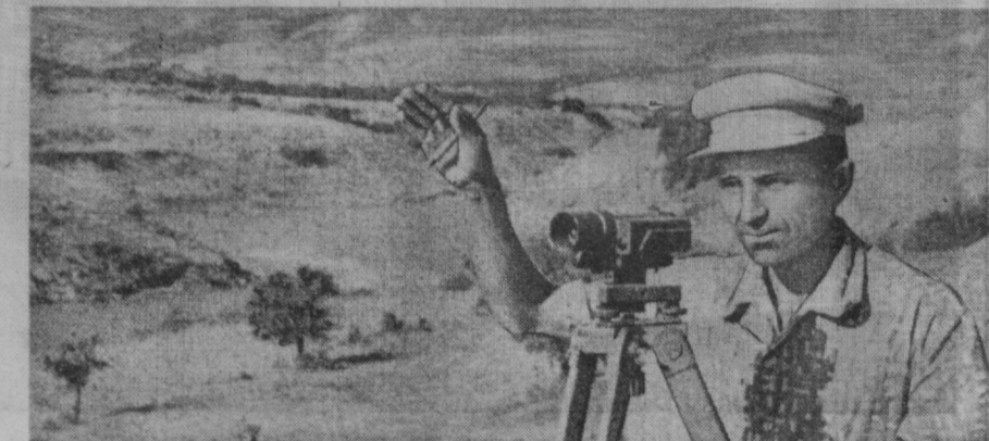
От станции Барраж до будущей Чарвакской ГЭС строится железная дорога, которая свяжет Ташкент с Чарваком. На отдельных участках идет укладка рельсов. На снимке слева: строитель механизированной колонны № 18 А. П. Иванов производит выверку трассы. На снимке справа: студенты 3-го курса механического факультета Ташкентского технического института Мулдашев Джумраев и Урубай Кучкаров в числе других 35 студентов старших курсов этого факультета решили научиться водить хлопкоуборочные машины. В сезон уборки они будут помогать хлопководам быстрее собрать урожай «белого золота». Студенты проходят подготовку в Ташкентском техникуме механизации сельского хозяйства.
