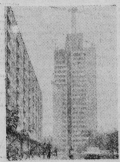
В Ворошиловском районе Москвы на проспекте Маршала Жукова возводится 25-этажный жилой дом, рассчитанный на 160 квартир. Этого первого в столице жилого дома с монолитным ядром жесткости строятся из типовых деталей.
