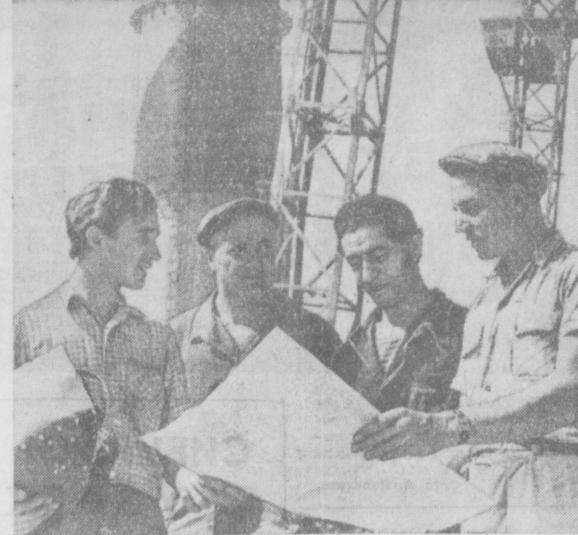
Славятся трудовыми делами на строительстве Ташкентской ГРЭС монтажники первого турбогенератора, которых вы видите на снимке В. Сироткина. Слева направо: Алим Лисецкий, Николай Рыбальченко, Роберт Качатурян и Алексей Козловский. Редкий день они выполняют меньше полутора норм.
