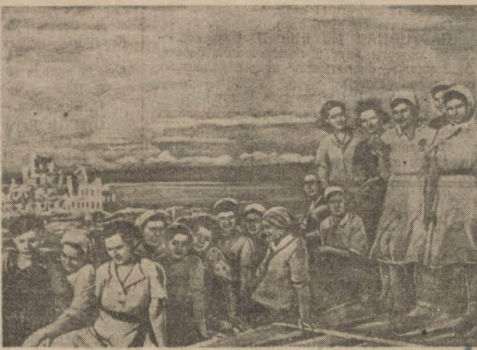
Сталинград. Бригада строителей, организованная председателем уличного комитета тов. Черкасовой, работает по восстановлению «дома Павлова». За отличную, стахановскую работу бригада награждена переходящим Красным знаменем. На снимке: бригада на крыше «дома Павлова». (См. корреспонденцию «В Сталинграде».)
